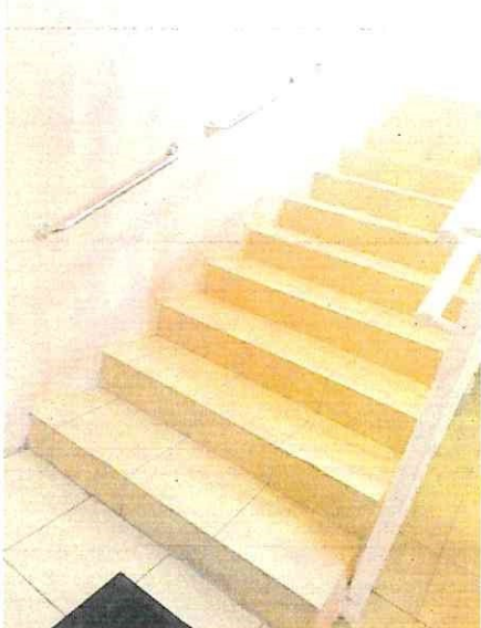
Фото № 29. Лестница внутренняя № 14
