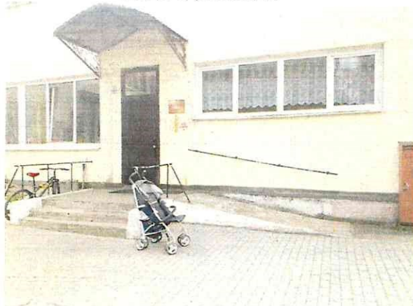
Фото № 24. Вход в здание №1
