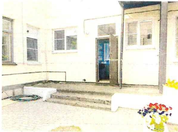
Фото № 23. Эвакуационная лестница № 2
