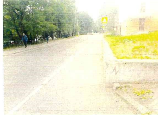
Фото № 3. Пути движения к объекту
